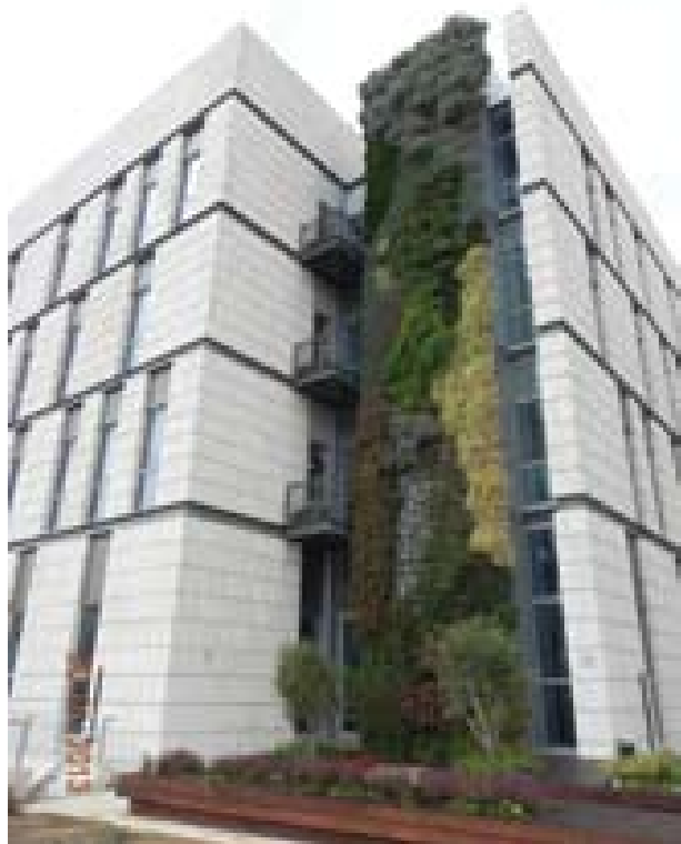
“קיר ירוק” חיצוני המורכב מצמחים חיים לגובה ארבע קומותיו של בניין משרדי חברת “שיכון ובינוי” באירופרט סיטי בלוד
